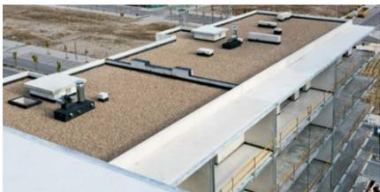
**CUBIERTA** Cubierta plana no transitable, visitable únicamente para conservación y mantenimiento, con doble capa de impermeabilización, aislamiento térmico-acústico y protección pesada. Contará con una placa de aislamiento extruido sobre la impermeabilización y una protección de grava.
