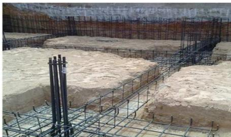
**CIMENTACIÓN.** Cimentación mediante losa de hormigón armado y, de acuerdo con los estudios geotécnicos realizados y con el proyecto de ejecución desarrollado por la dirección facultativa.
